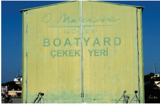
Kapalı Çevre-Dostu Bakım Onarım Çekme Yeri (Didim D-Marin)
