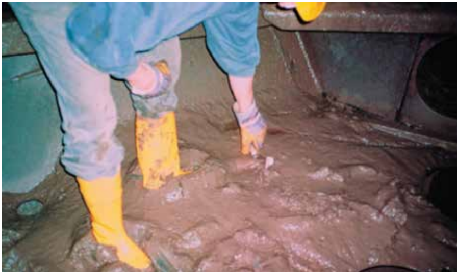
Şekil 9. Balast Tankından Sedimanların Uzaklaştırılması
